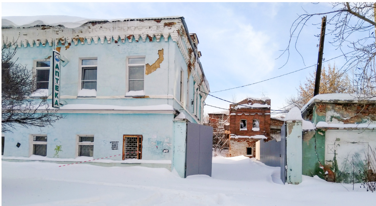
Рис. 7. Вид на хозяйственные постройки во дворе на ул. Ключевской, 3, 2023 г.
